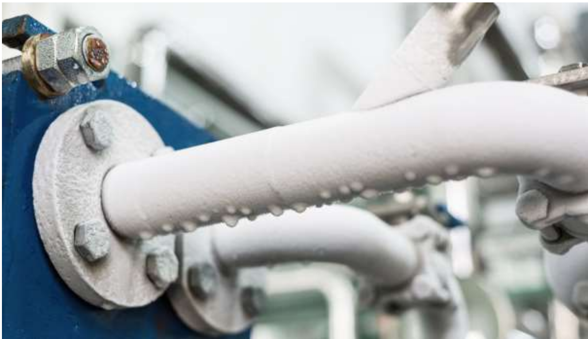
Fig. 1; Bevroren condens op de leiding van een koelmachine.
